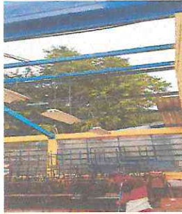
Sustitución de cubierta de lamina en todo el establecimiento educativo
