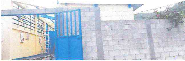
Sustitución de cubierta de lamina en todo el establecimiento educativo
