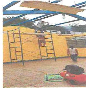
Sustitución de cubierta de lamina en todo el establecimiento educativo
